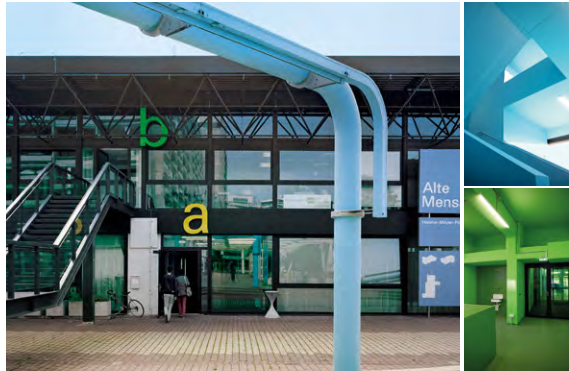
Die „Alte Mensa“ des Studentenwerks München wurde von 2009 bis 2012 nach neuesten Sicherheitsanforderungen saniert.
